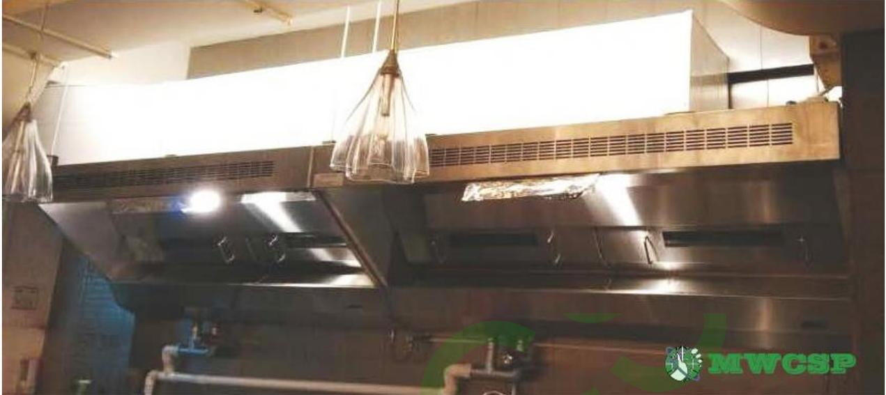
「**固化煙罩**」有別於傳統蒸氣煙罩及運水煙罩，運用低溫凝結油脂隨著水管排出，只需約**兩大瓶礦泉水**水量即可運轉，建議每日營業日開始時進水、結束時放水，節能、省電、環保。
